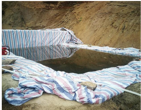
照片 2-21 蓄水池工程
