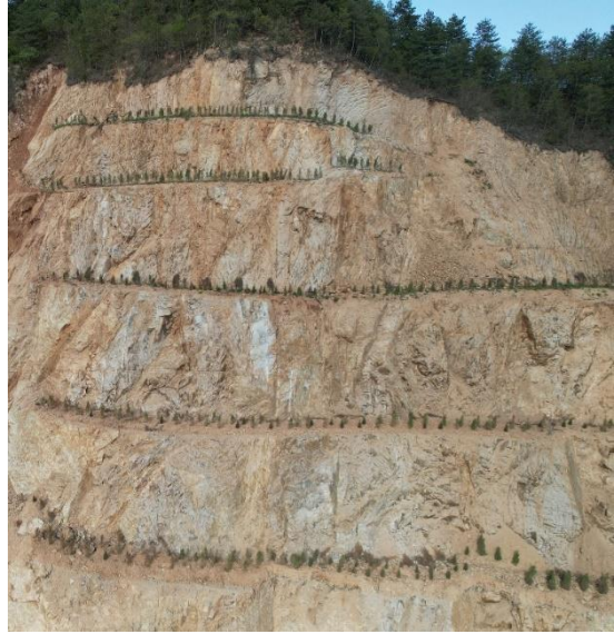
照片 2-7 治理后照片
