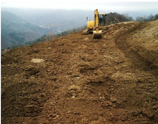
照片 2-8 覆土工程
