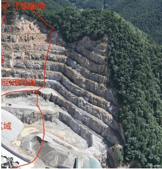
照片 2-6 治理后照片
