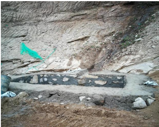
照片 2-20 蓄水池工程
