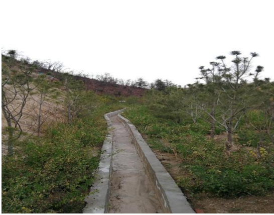
照片 2-18 排水渠工程
