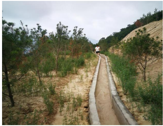
照片 2-19 排水渠工程
